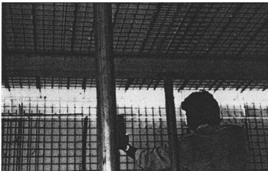
Фотография б: выравнивание стены с помощью шнура (шпагата)
